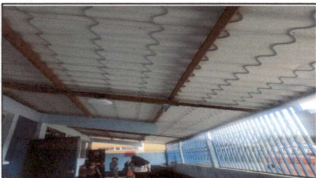
Foto 3: 2.3 Sustitución de estructura de soporte de metal, por metal
