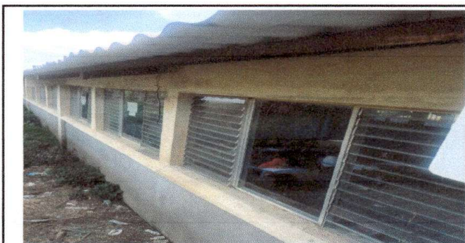
Foto 5: 5.3 Sustitución de ventanas de aluminio por venta PVC 3
