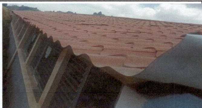
Foto 1: 1.1 Sustitución de laminas, por láminas troqueladas aluzinc calibre 26
