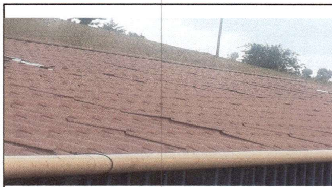
Foto 4: 7.2 Sustitución de canal de pvc
